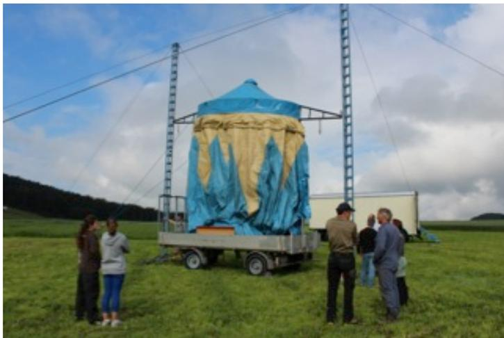
Abb. 5: Zeltaufbau Kuppel hochziehen
