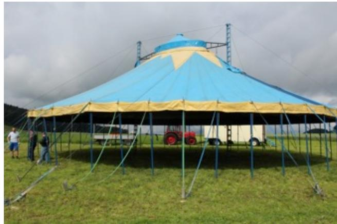
Abb. 7: Zeltaufbau Rondellstangen einstecken
